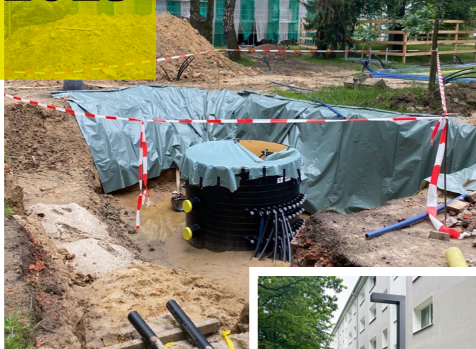
In der Rehre: Modernisierung mit Nahwärme
