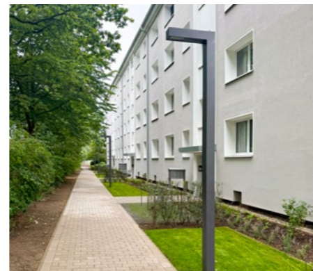
In der Rehre: neue Vorgärten nach Fertigstellung der Modernisierung
